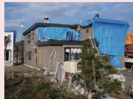
屋根の板金と野地、たるきが飛散 サッシのガラス破損（南面は割れたが、他は一部のみ） 外壁の損傷（飛来物の衝突による）
